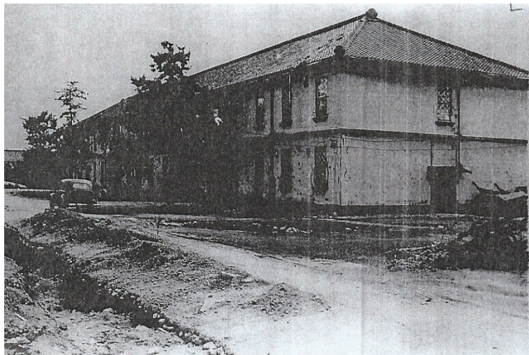
図 4 将校用捕虜棟 (1号棟)
