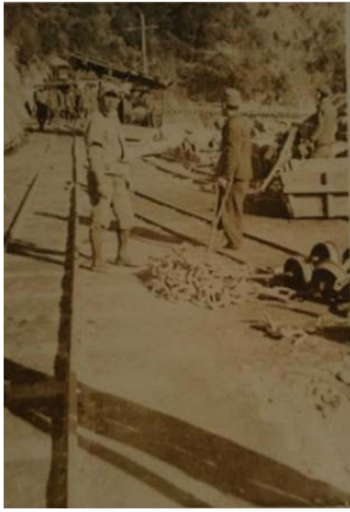
68. 満島工事現場のトロッコ 写真提供：北澤洋太郎
